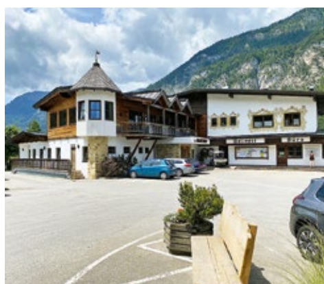
Das zentrale Gebäude am Platz beherbergt Rezeption, Restaurant und Sanitär. Lieblingsplatz von Platzchef Andreas Brunner ist aber der Hofladen Brantlhof. ▶
