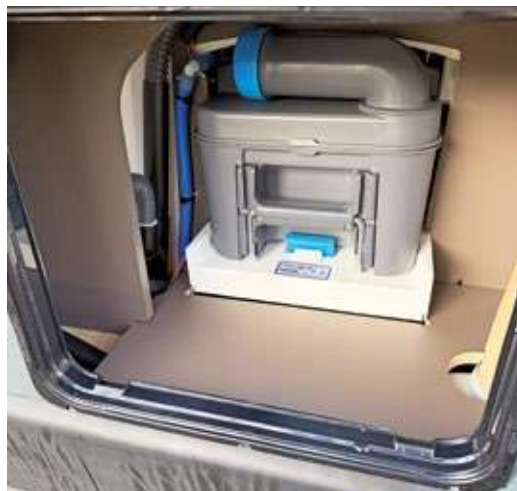
Der Toilettenschacht für die Kassette ist nicht vollständig gegen Nässe gekapselt.
